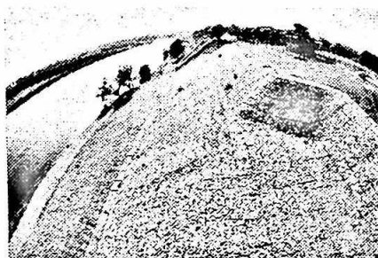
1.11-rasm. Gabion konstruksiyalari yordamida qiyaliklarni mustahkamlash.
