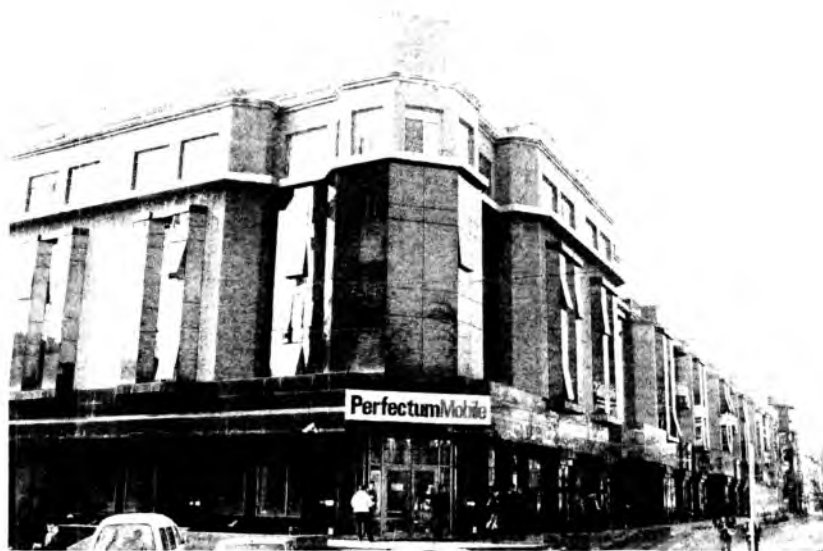
13.95-rasm. Toshkent shahrida bunyod etilgan o'ziga xos yechimdagi ko'p funksiyali binolaridan birining umumiy ko'rinishi
