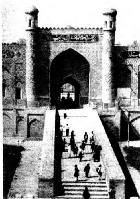
13.34-rasm. Qo'qondagi restavratsiya qilingan Xudoyorxon o'rdasi
