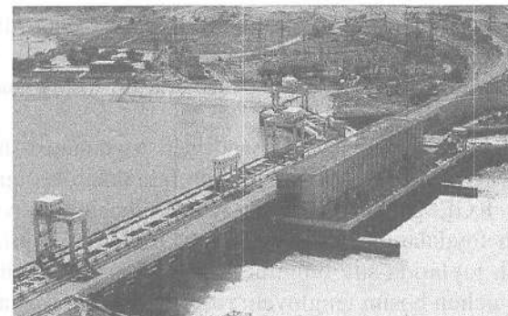
3.9 – rasm. Tuyamuyin gidroelektr stansiyasi.
