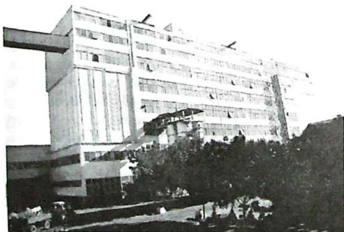
20-rasm. Namangan viloyati Uchqo'rg'on don mahsulotlari kombinati (Shvetsariyadagi Byuler firmasi loyihasi asosida qurilgan, unumdorligi 500 t/s bo'lgan 3 navli (oliy, birinchi va ikkinchi) unlar ishlab chiqaradi.
