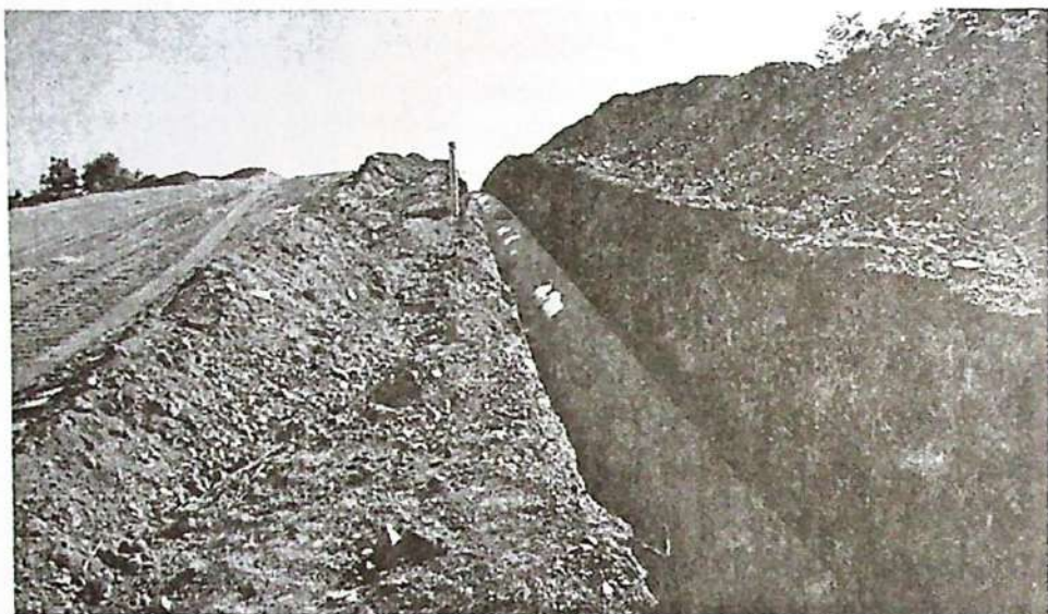
2.2-rasm. Gaz quvur tarmoqlarini yer ostidan o'tkazish.
