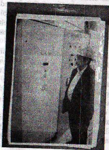
17.1-rasm . Nasos agregatining asinxron elektr yuritmasini boshqarish uchun 200 kWt quvvatli elektr tejamkor qurilma umumiy ko'rinishi
