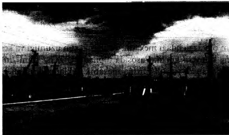
14.1-rasm. Kuchlanishi 35 va 10 kV li havo elektr liniyalarining podstansiyaga kirishi va chiqishi.
