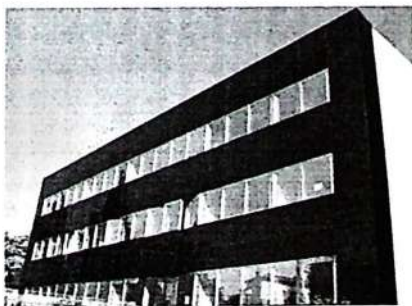
84-rasm. Integratsiyalashgan yupqa plyonkali quyoshli modullarni binoga o'rnatilgandagi holati
