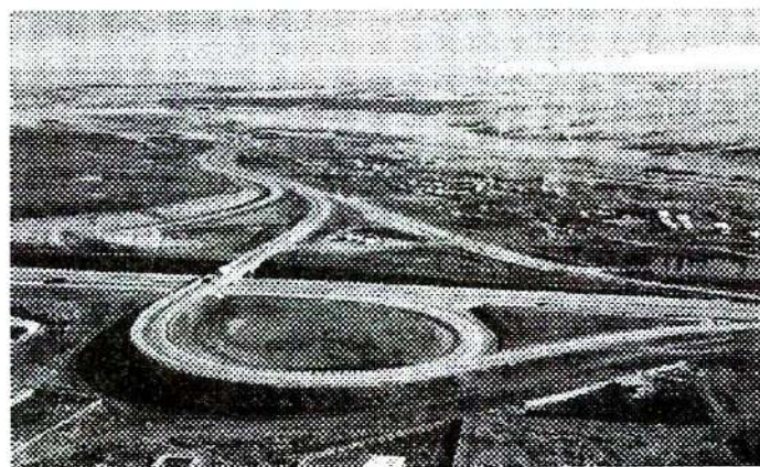
9.9-rasm. Avtomobil yo'llarining yo'lo'tkazgich asosida har sathdagi kesishishi
