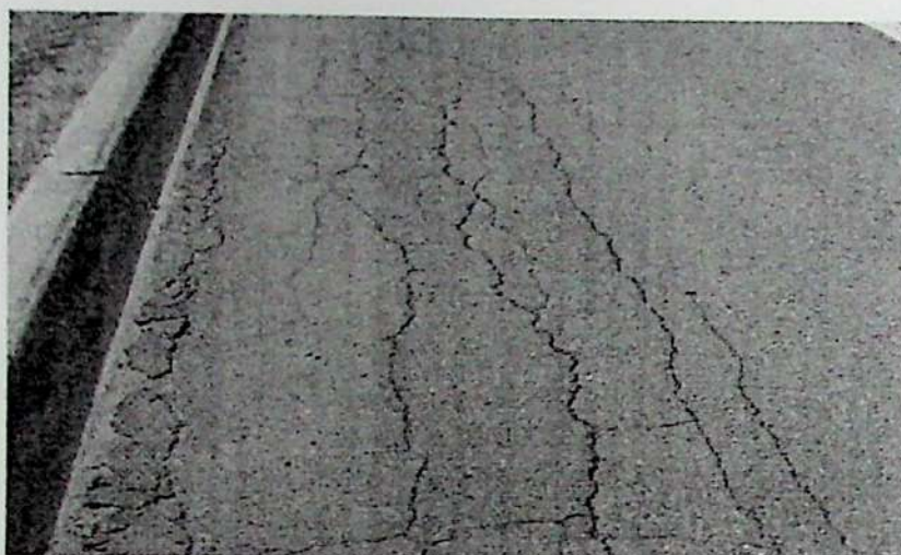
6.6-rasm. Yuk ta'siridagi yoriqlar
