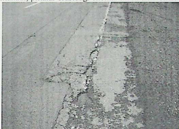
6.15-rasm. Qoplama chetlarining buzilishi.
