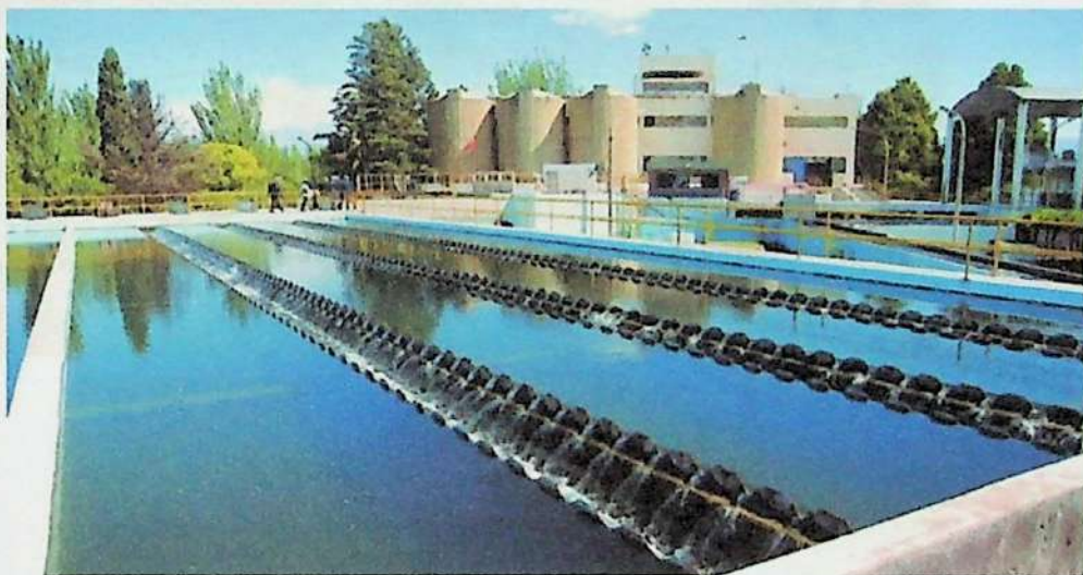
1.14-rasm. Suvni filtrlash bosqichi.
