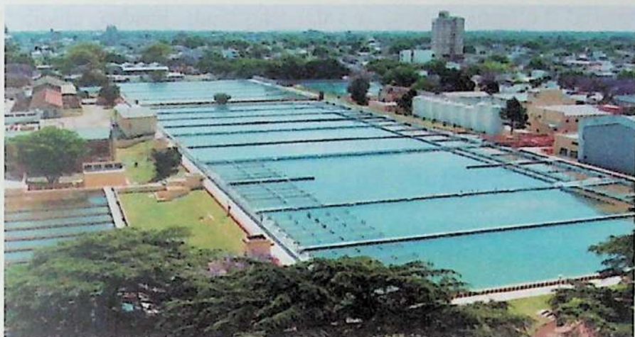
1.13-rasm. Suvni dastlabki filtrlash jarayoni.
