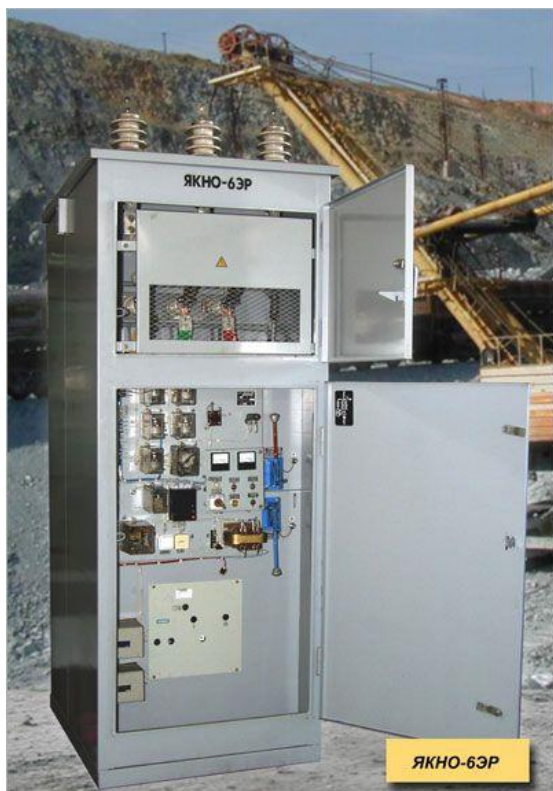
4.20-rasm. Qayta ulash punktlari: a) YAKNO-6ER, b) YAKNO-10U1.
