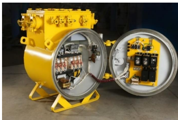
5.17-rasm. Qo'lda boshqariladigan, portlashga xavfsiz PRV-1031A ishga tushirgich elektr ulanish sxemasi.
