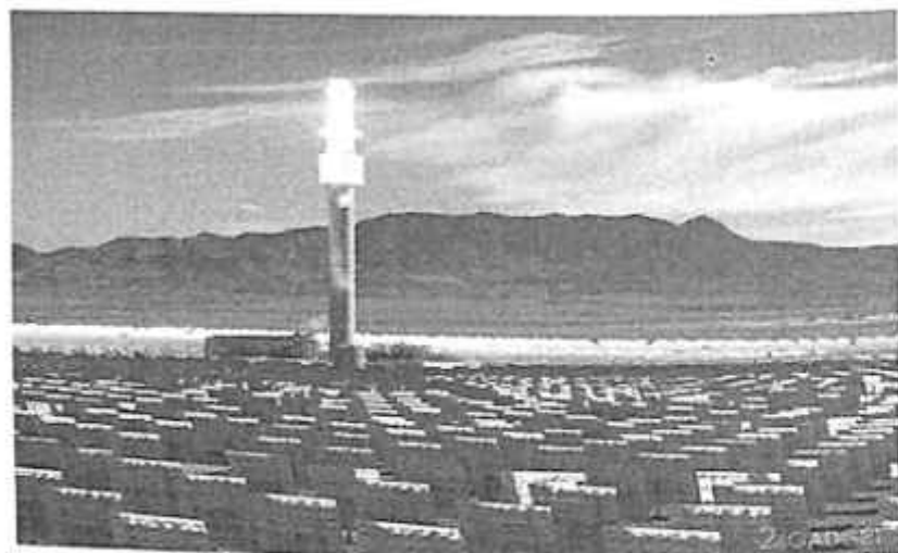
23-rasm. Dunyodagi eng kuchli quyosh elektr stansiyasi (Avstraliya).
