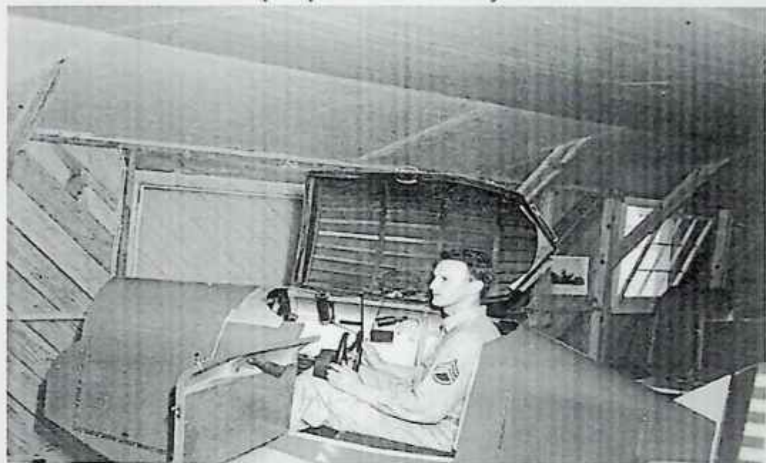
9.3.1-rasm. "Link Trainer" dastagi simulyatori
