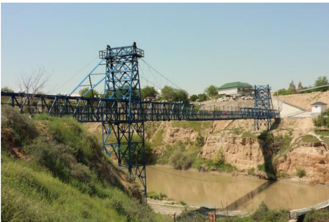
1-rasm. Osma – vantali ko‘prikning umumiy ko‘rinishi.
