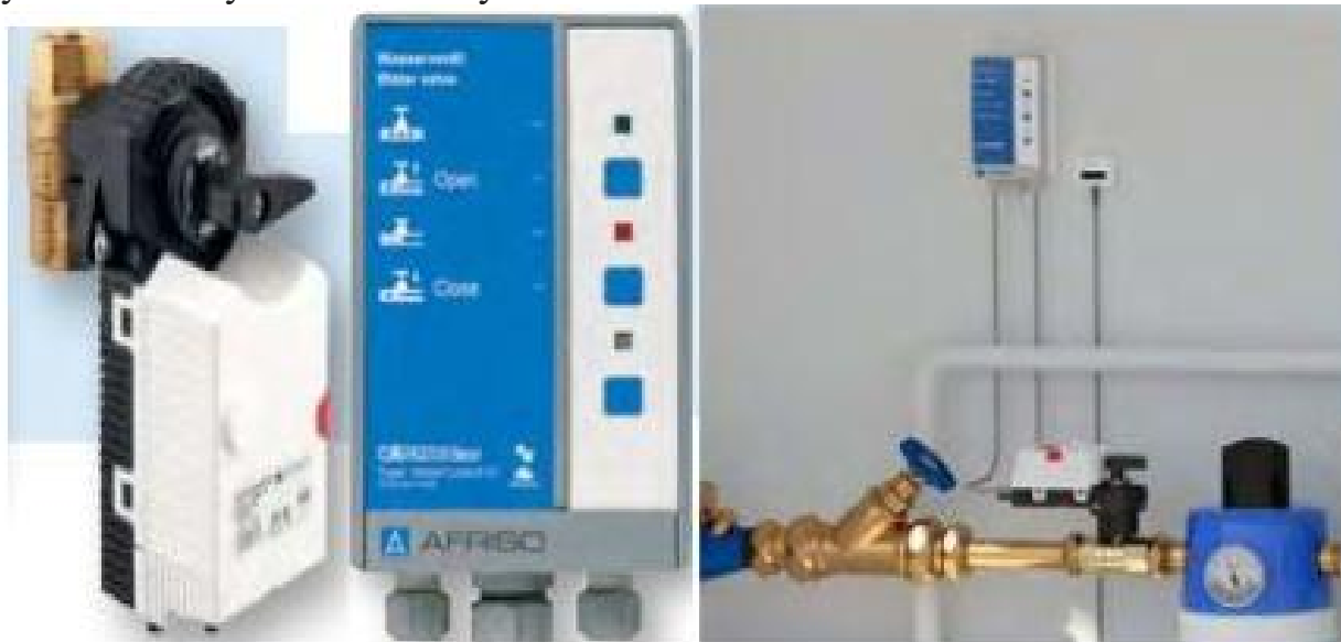
2-rasm. Binolarda suv quvurlarini yopish va ochishni qo'lda yoki masofadan boshqarish asboblari.
