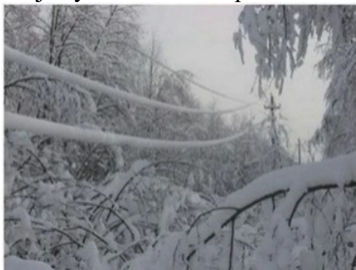
1-rasm. Elektr uzatish liniyalarini muzlama qoplashi
