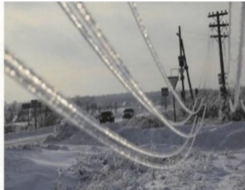
1-rasm. Elektr uzatish liniyalarini muzlama qoplashi
