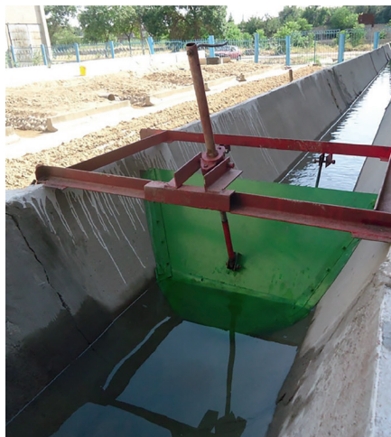
2.8-расм. Параболик щитли сув дарвозаси
