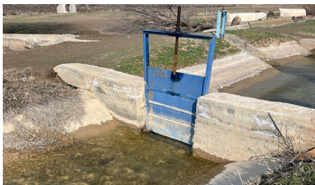
2.2-расм. Ясси сув дарвозали сув тўсиш иншооти
