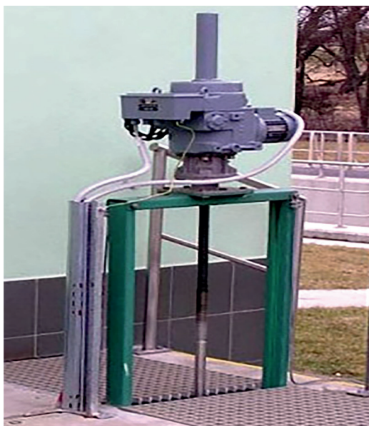
2.6-расм. Электрлаштирилган сув дарвозаси
