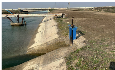
2.3-расм. Ясси сув дарвозали сув олиш иншооти
