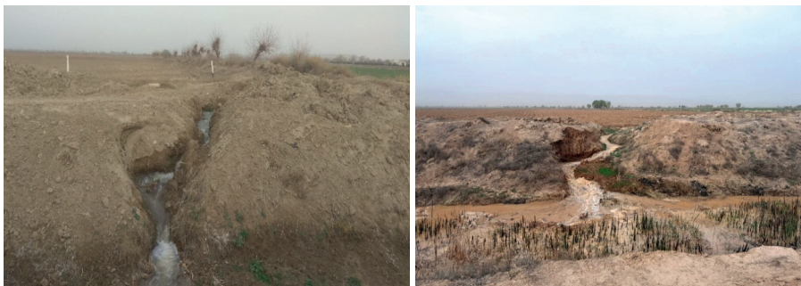
4.4-расм. Сувни коллектор-дренаж тармоқларига ташлаб қўйиш
