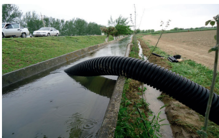
15-расм. Лоток тармоғидан сифон ёрдамида сув олиш
