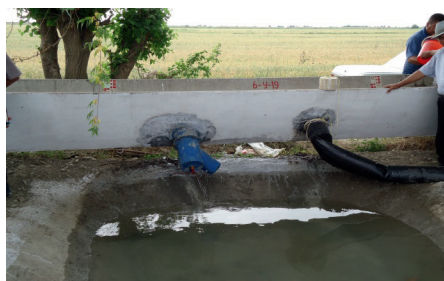
16-расм. Лоток тармоғидан қувурли сув чиқаргич ёрдамида сув олиш
