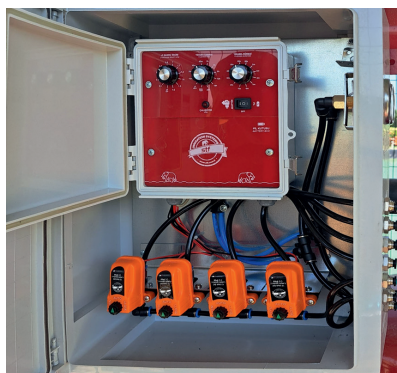
10-расм. Қумли филтрларни ювиш автоматик бошқарув тизими
