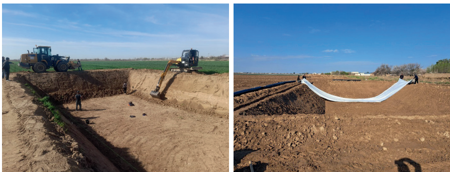
3-расм. Ҳовуз-тиндиргичларни тайёрлаш жараёни
