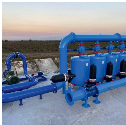
5-расм. Ғўзани томчилатиб суғориш тизими насос станциялари кўриниши
