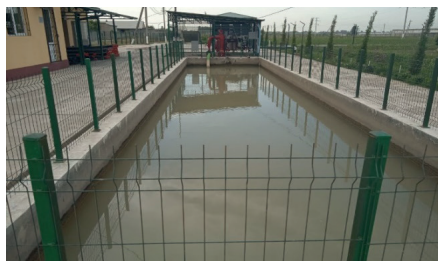
4-расм. Томчилатиб суғориш тизимидаги ҳовуз-тиндиргич
