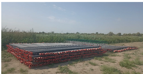
16-расм. Стационар ёмғирлатиб суғориш тизимининг мандалли магистрал қувурлари
