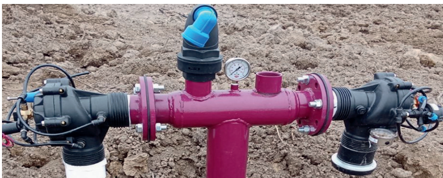
14-расм. Стационар ёмғирлатиб суғориш тизими гидрантлар
