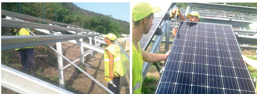
3.5-расм. Қуёш фотоэлектрик станцияларини монтаж қилиниши
