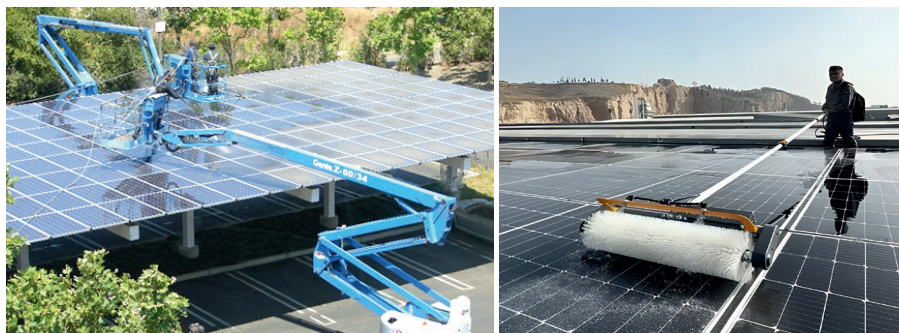
3.7-расм. Қуёш панелларини тозалаш жараёни
