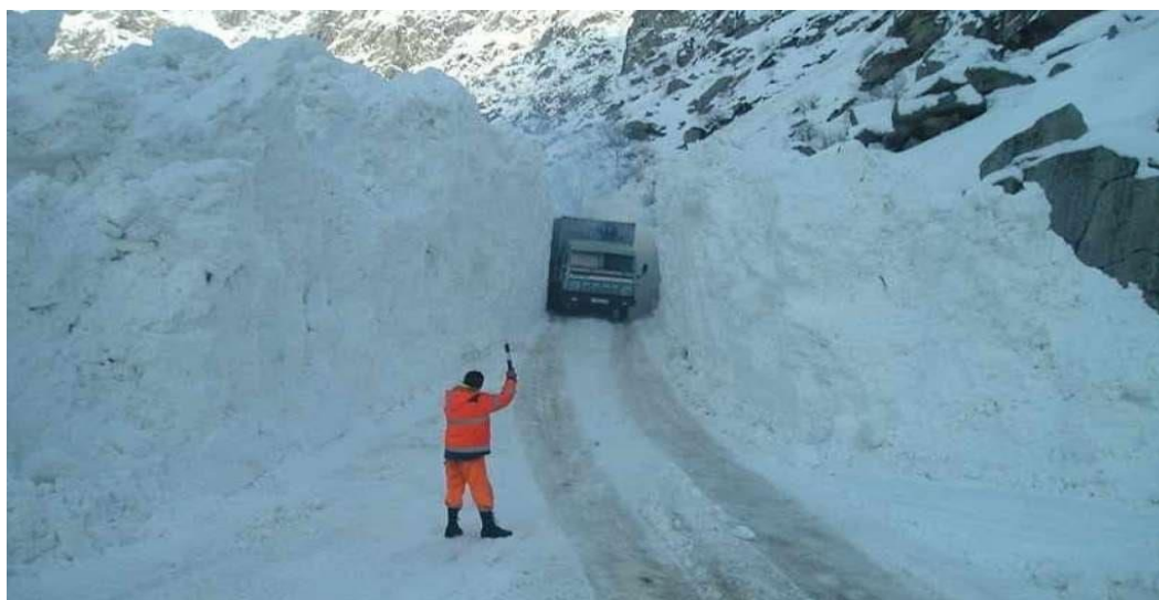
Рисунок 1. Схода снежных лавин на автодороги Душанбе - Худжанд
