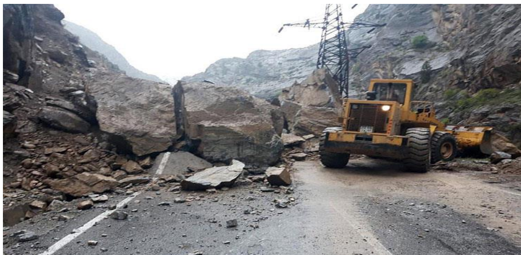
Рисунок 2. Камнепады на 94-95 километре автомобильной дороги Вахдат-Рашт-Ляхш
