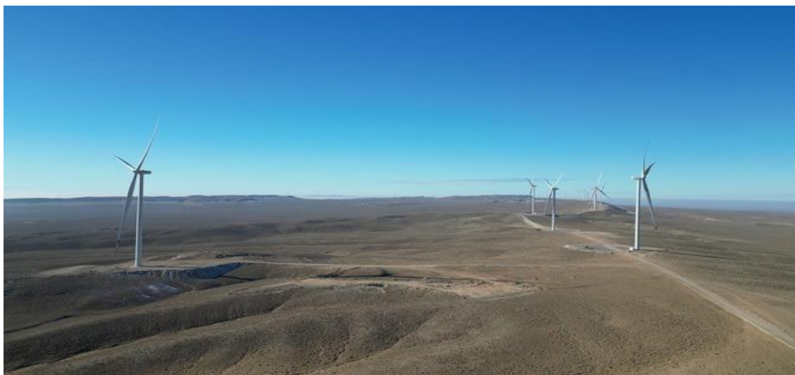
2-rasm. Shamol elektr stansiyasi
