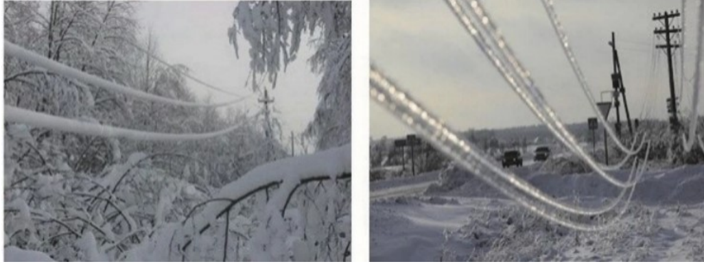
1-rasm. Elektr uzatish liniyalarini muzlama qoplashi
