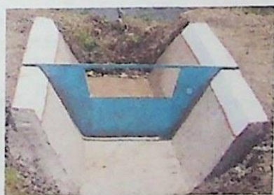
1.1-rasm. Chipoletti suv tashlagichining umumiy ko'rinishi
