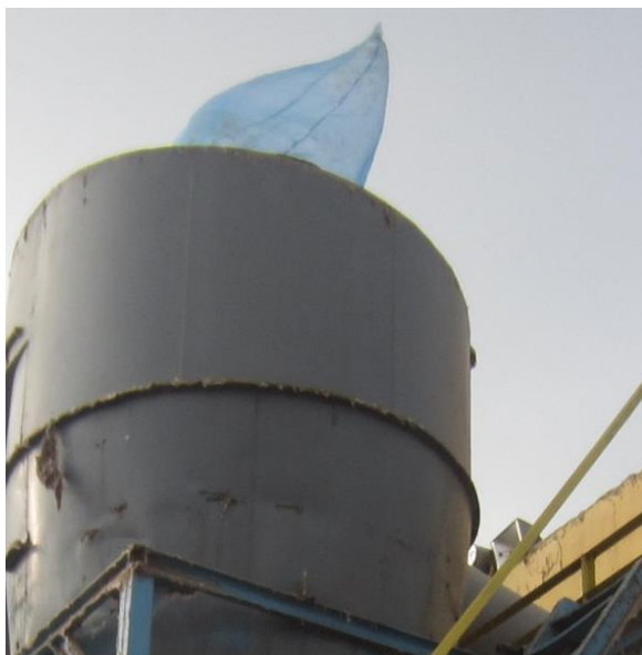
4-rasm. Siklonning atmosferaga chiqish patrubogiga yumshoq qopli filtrni o'tnatilgandagi ko'rinishi
