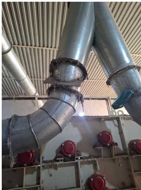
1-rasm. UXK paxta tozalash agregatini takomillashtirilgan aspiratsiya tizimini ko'rinishi
