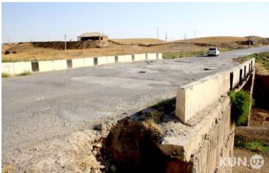
6.13-rasm. Ko‘prikga yaqinlashuv, ko‘prikni yo‘l bilan birlashuv qismi.
