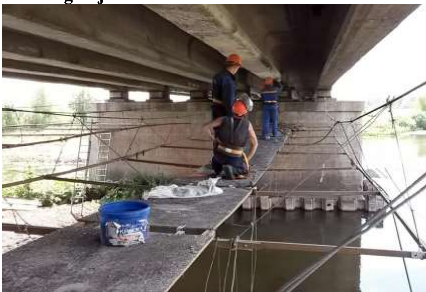
6.9-rasm. Ховонларда туриб ораліқ қурулма тўсинларини таъмирлаш.
