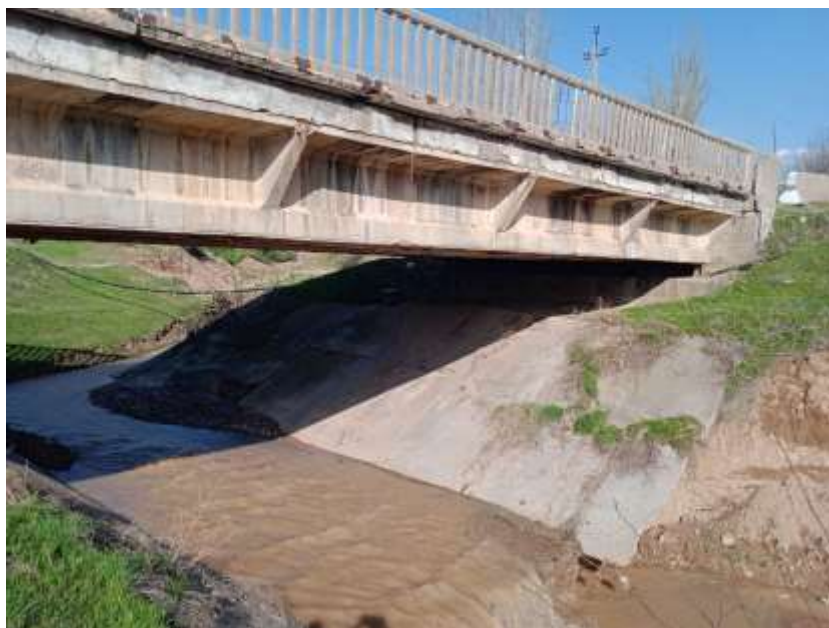
6.10-rasm. Бир оралик тўсинлик сой устидан ўтган кўприкни кўриниши.
