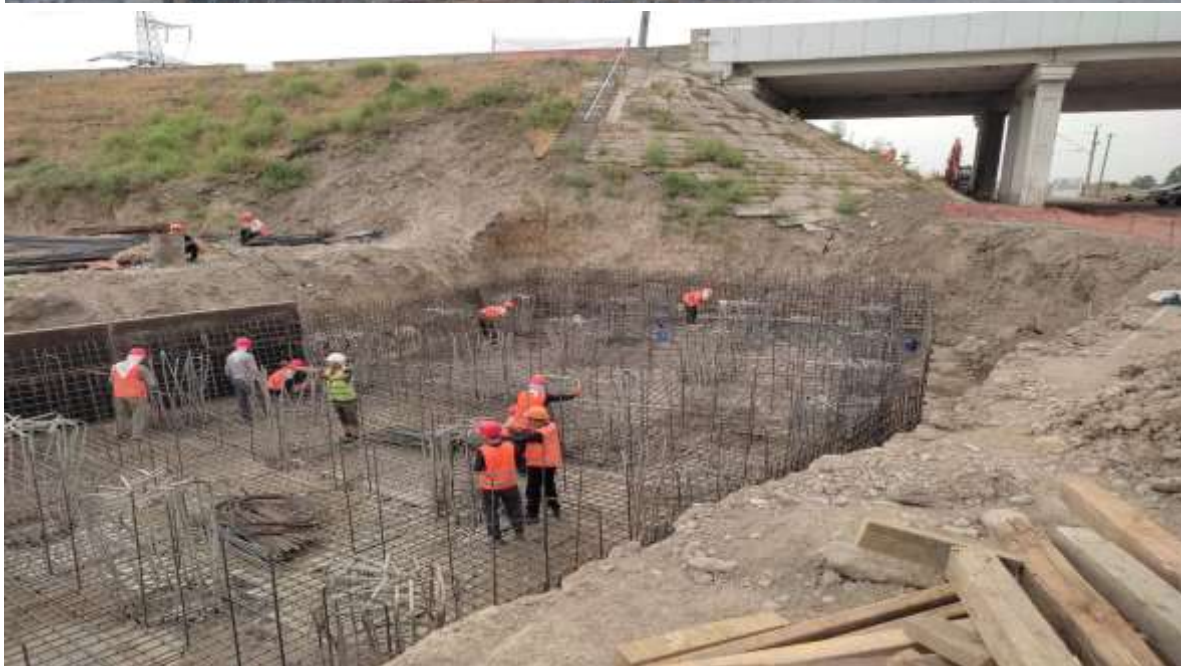
2.2-rasm. Ochiq xandaklarda poydevorni armaturalaui.
