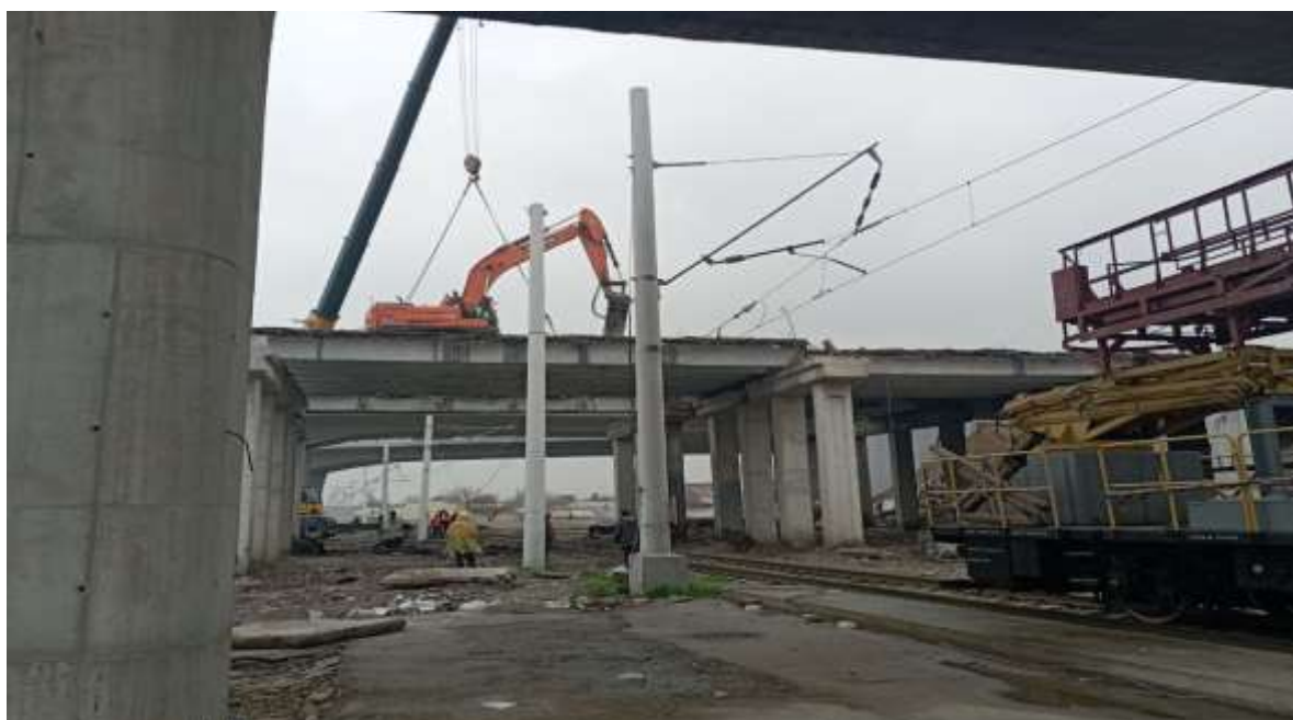
1.1-rasm. Toshkent xalqa avtomobil yo‘lidagi avtomobil yo‘lo‘tkazgichini demantaj qilish ishlari.
