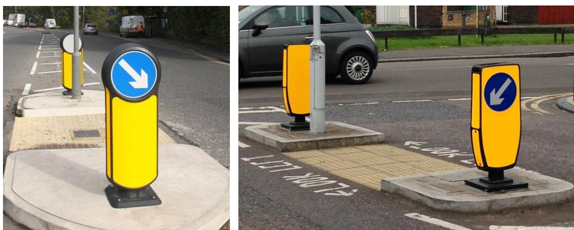
5.14-rasm. Yo'naltiruvchi ustunchalarni yo'lning ko'ndalang kesimida o'rnatish.
