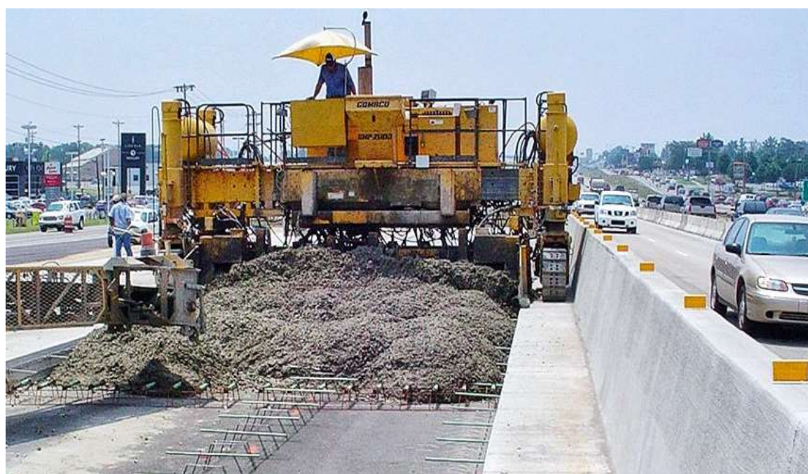
4.19-rasm. Sementobeton qoplamasini qurish bo'yicha texnologik jarayonlardan lavhalar
