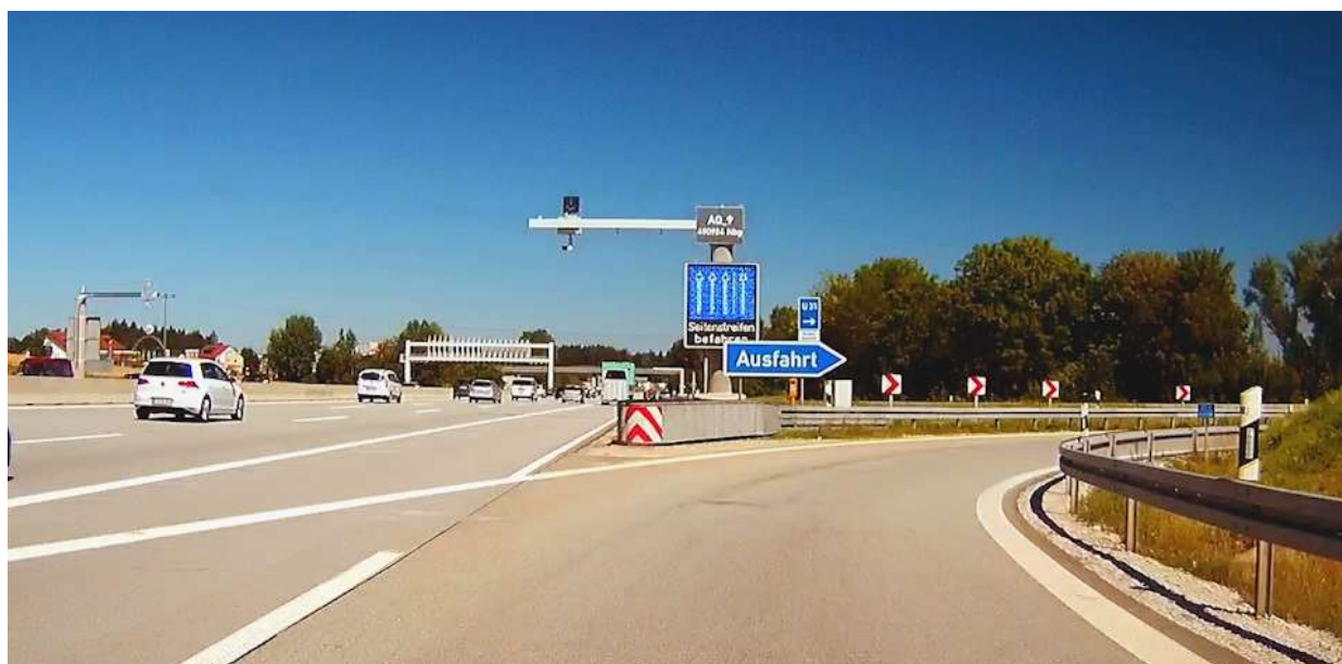
1.8-rasm. Zamonoviy avtomagistrallarni umumiy ko‘rinishi
