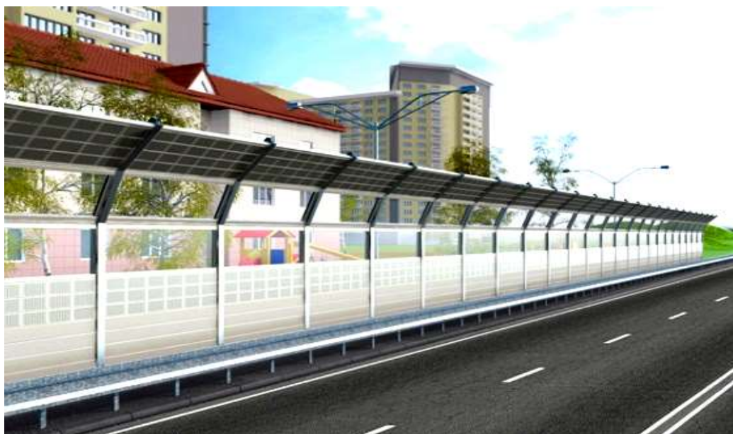
6.14-rasm. Shovqin qaytaruvchi to‘siqlarning avtomobil yo‘llarida qo‘llanilishi: a- G-simon ekran ikki qiyalikli 12^\circ + 12^\circ ; b-to‘g‘ri ekran; b-G- simon ekranbir qiyalikli 12^\circ
